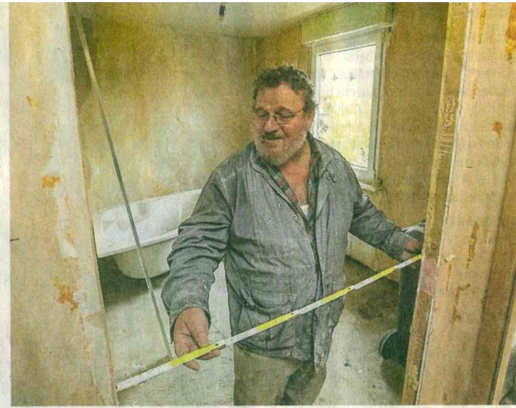
Hans-Jörg Müller verbringt viel Zeit auf der Baustelle für das neue Familienheim. Es wird an die Bedürfnisse seiner Tochter angepasst. FOTO: TONI SÖLL
