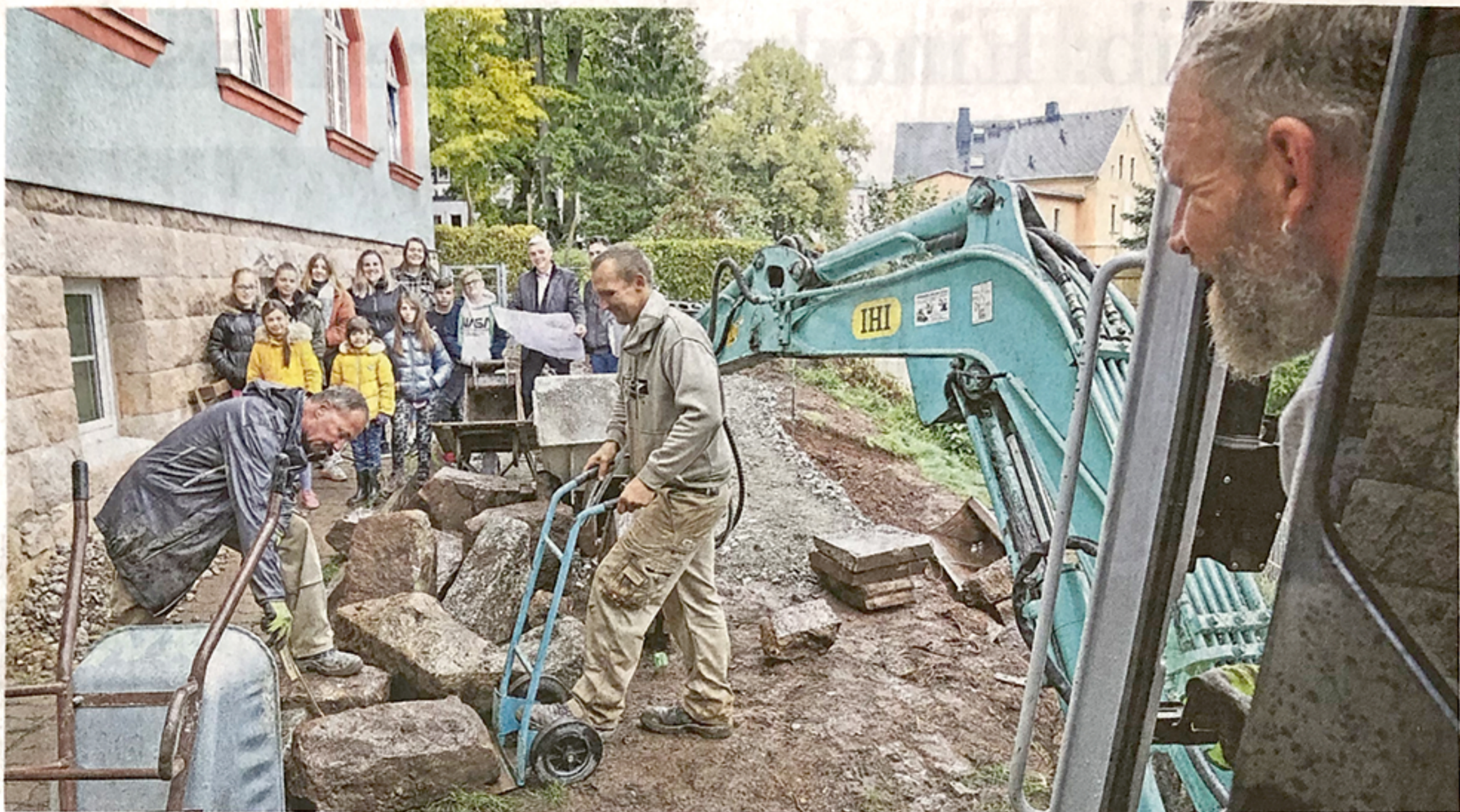
Gespannt verfolgen die Kinder und Jugendlichen der Wohngruppe des Zwickauer Kinderhaus-Vereins die Bauarbeiten hinter der grünen Villa in Planitz. Der Hang wird derzeit von der Firma Gala-Bau zu einem Garten mit Terrasse umgestaltet. FOTO: RALPH KÖHLER
